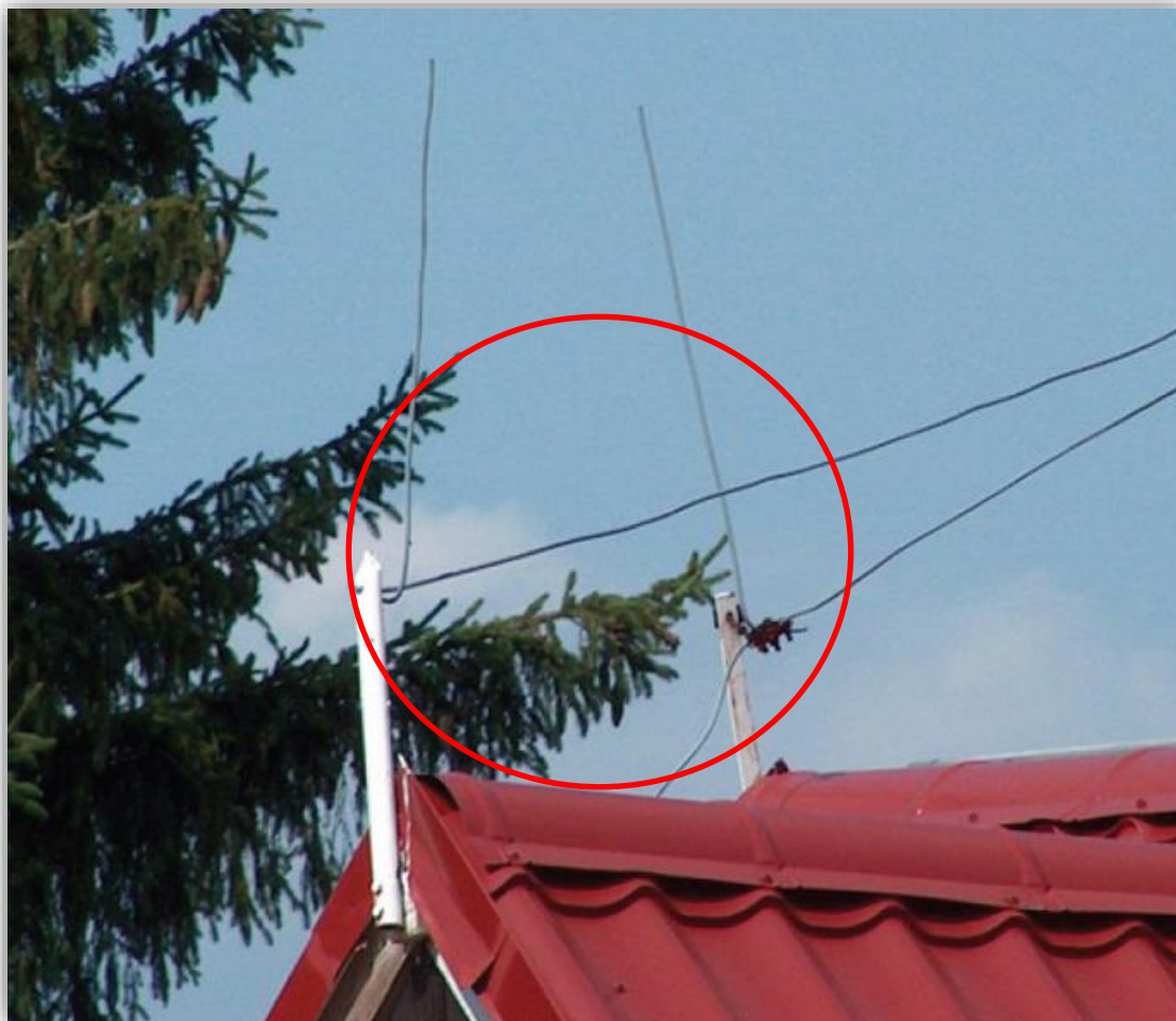
Przykład wykonania zwodów nad dachem krytym blachą.
