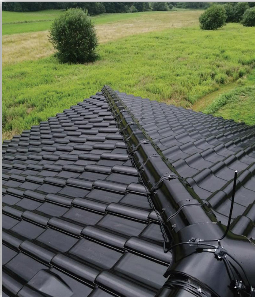
Siatka zwodów w kolorze pokrycia dachowego
