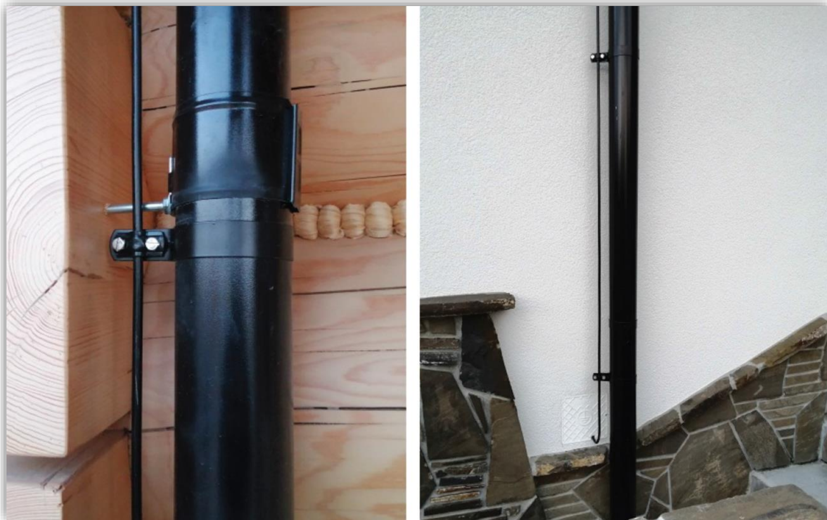
Przewód odprowadzający na opaskach dopasowany do systemu rynnowego
